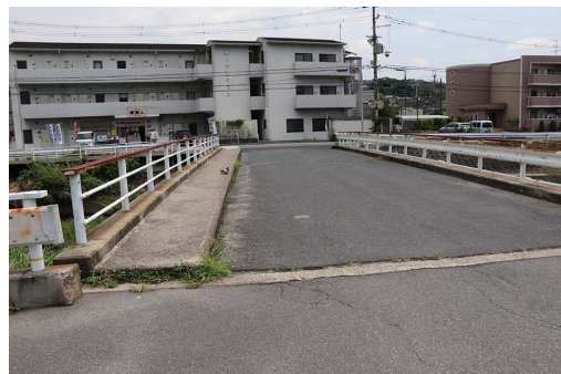
現況の文殊橋
