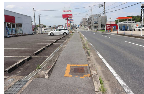
③現況の歩道
