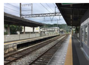
【整備済】⑬内方線付点状ブロックへの改修
