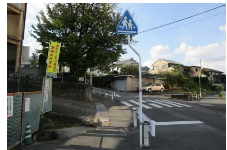
【整備済】③標識の移設
