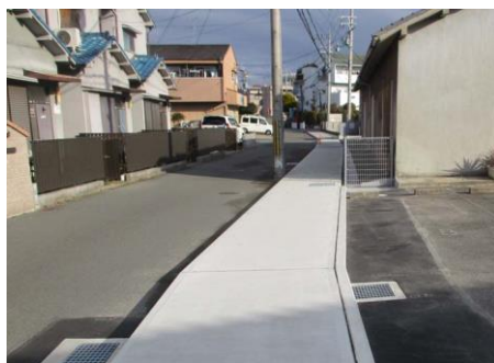
【整備済】既設水路の有蓋化による歩行者空間の整備
