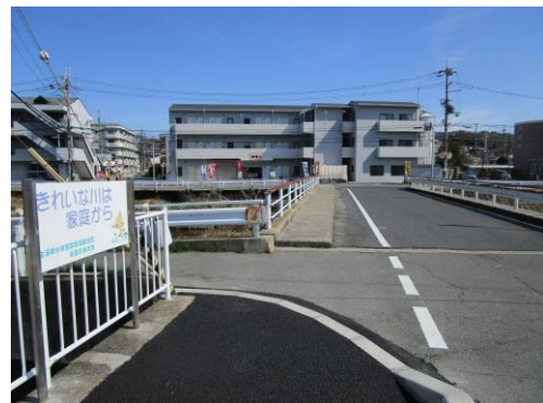
【整備済】現況歩道の改修（文殊橋）
