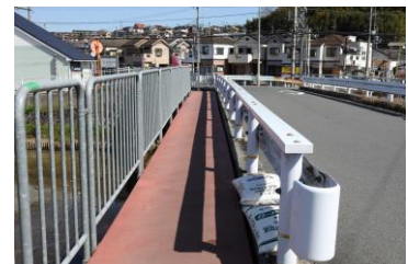
【整備済】②滑り止めの設置
