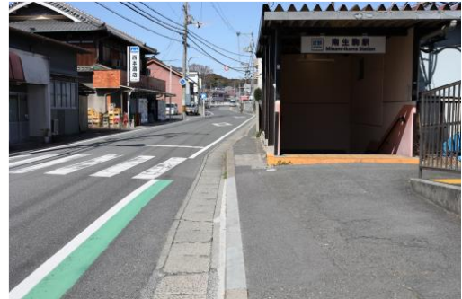
【整備後】①歩道舗装、②縁石、側溝蓋
