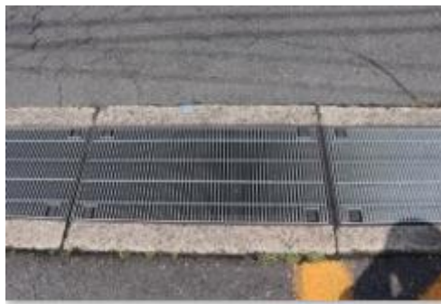
【整備済】側溝蓋の更新
