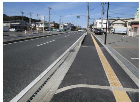
【整備済】点字ブロックの設置（東側歩道）
