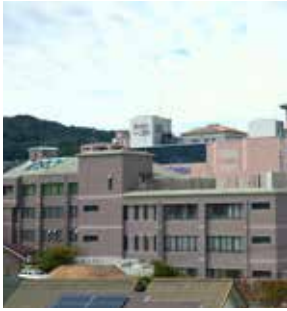
トイレの改修を行う セラビーいこま
