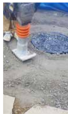
公共下水道の整備を進めました
