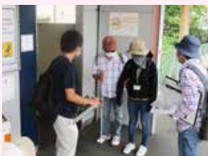
誘導(点字)ブロックが無い 駅構内のトイレ入口
