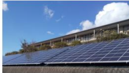
5号機 小瀬保健福祉ゾーン2 2021.11完成
