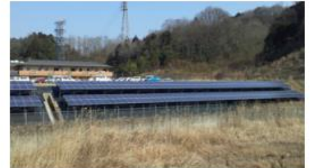
3号機 小瀬保健福祉ゾーン1 2016.3完成
