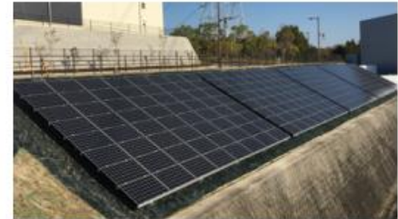
4号機 学研高山地区法面 2017.12完成
