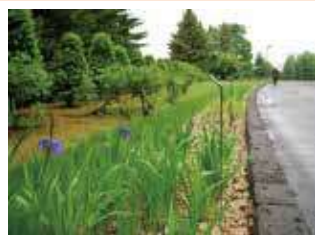
グリーンインフライメージ (レインガーデンによる雨水貯留浸透機能の向上 出典：札幌市 HP)
