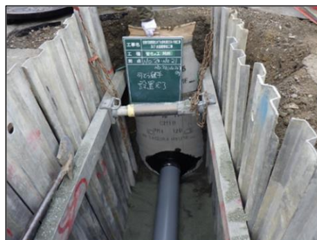
管渠布設工事
