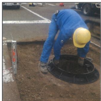
マンホール蓋入替工事
