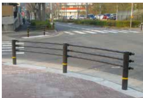
令和元年度に防護柵を設置した白庭台の交差点
