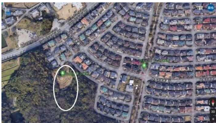
航空写真 ハザードは白丸付近（土石流）
