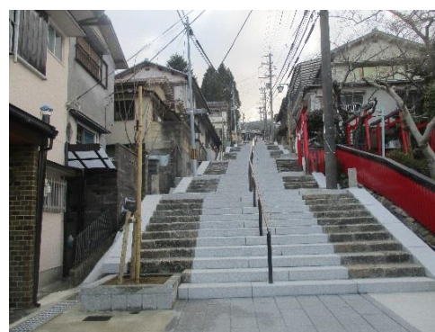
仲之町工区の施工前(左)、施工後(右)
