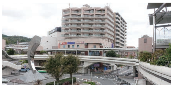
1 近鉄生駒駅北口ロータリー
