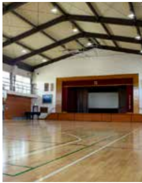
真弓小学校の体育館の屋根と床面を改修しました
