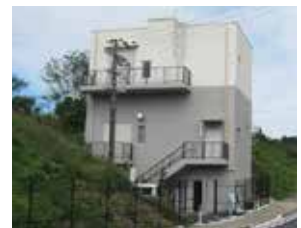
新設した新小瀬中継所
