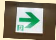
白色に緑文字の通路誘導灯
