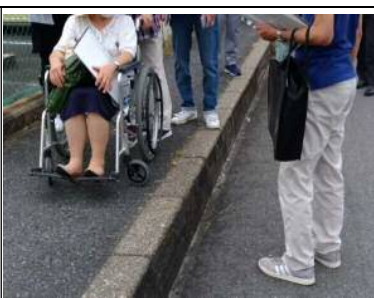
国道168号現道は道路と歩道の段差が大きく危険。
