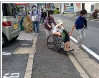
国道168号現道は歩道が横断方向に傾斜し危険なところがある。
