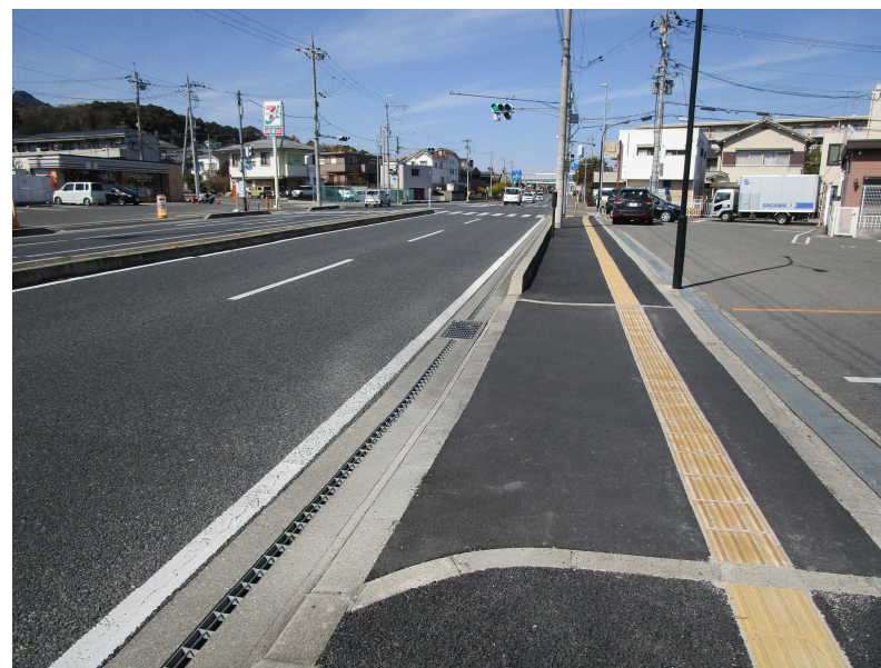
完了写真②(東側歩道)
