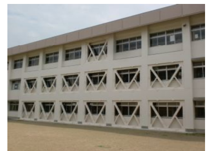
公共施設の耐震改修
