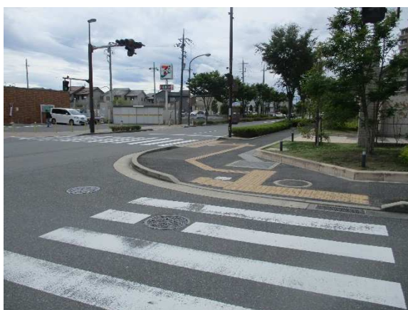
対策工事箇所
