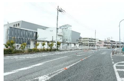
駅周辺公共施設 (小瀬町)
