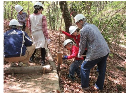
園路の階段を修理
