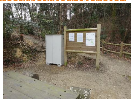
物置設置完了
