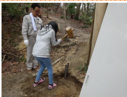
20本の杭を打ち込んで固定
