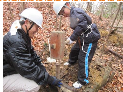
カケヤで杭を打ち込みます
