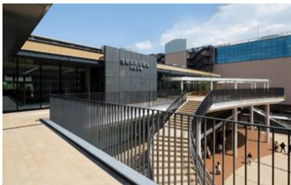
生駒駅前図書室 木田文庫
