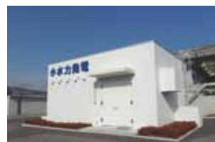
小水力発電 (山崎浄水場に設置)
