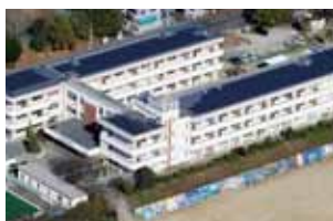
太陽光発電 (公共施設の屋根に設置)
