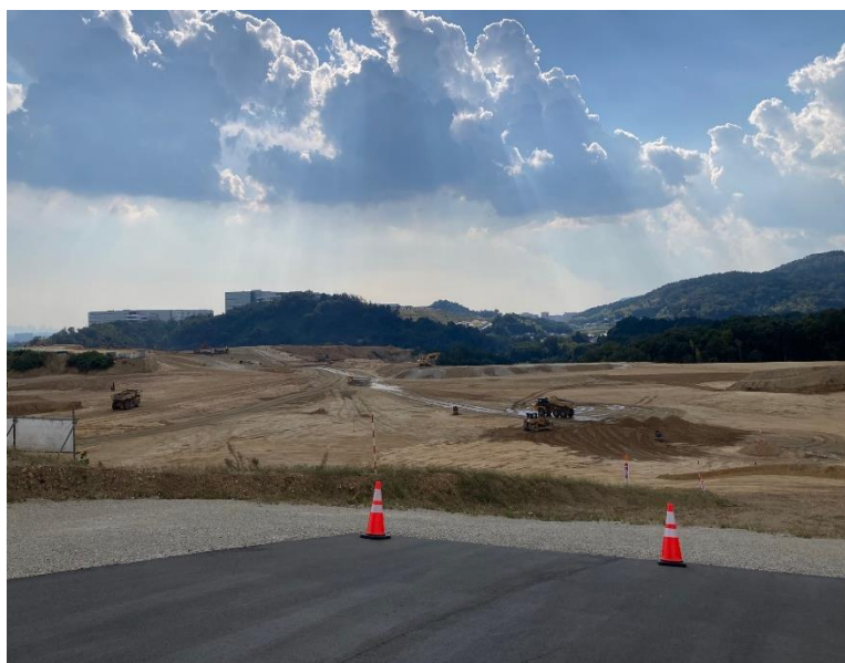
造成工事中の彩都東部地区 C 区域 ↓
