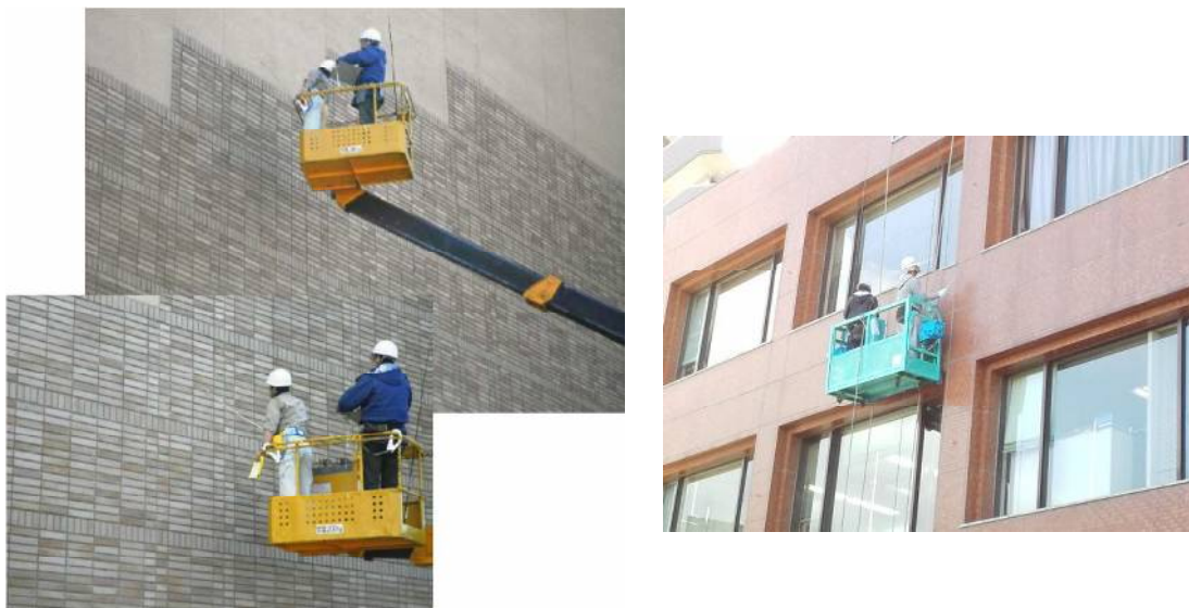
〈外壁打診調査状況〉
