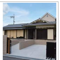
築55年の平屋建ての外観。住宅として使われていました。
