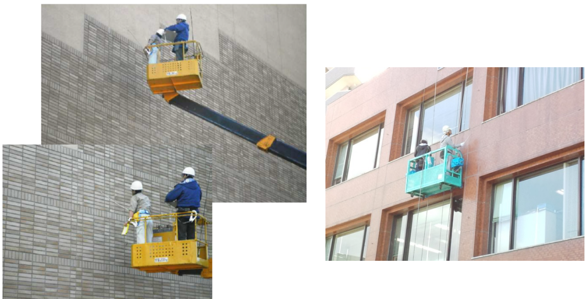
〈外壁打診調査状況〉
