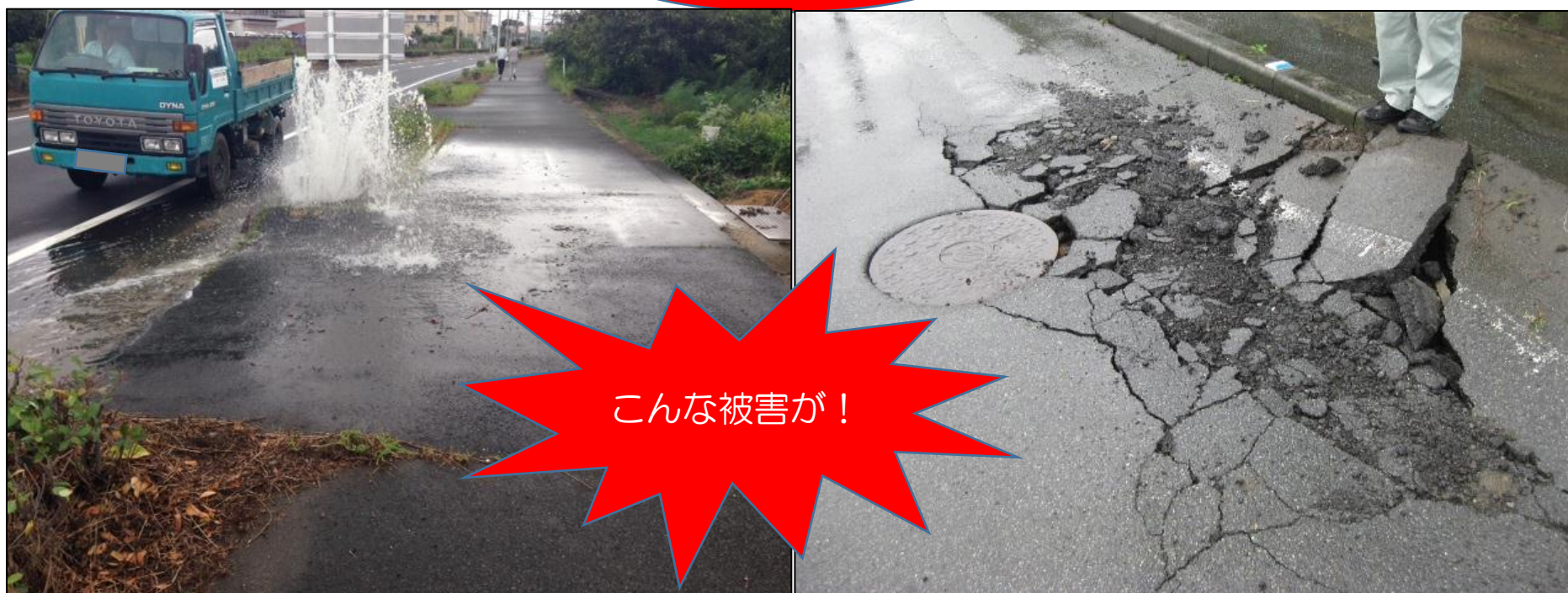
【マンホールからの下水噴出】
