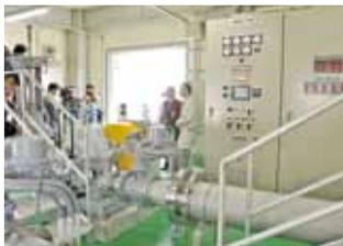
発電能力は40kWh。写真下のパイプの右から水が流れ、その圧力で水車を回し、発電します
