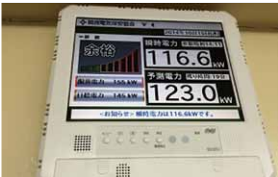
市内小・中学校などに設置する「デマンド監視装置」。電力使用量が数値化される他、使用量が多くなると警報音で知らせる。
