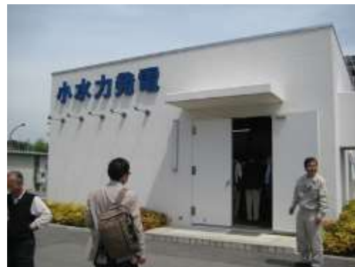
山崎浄水場発電所棟
