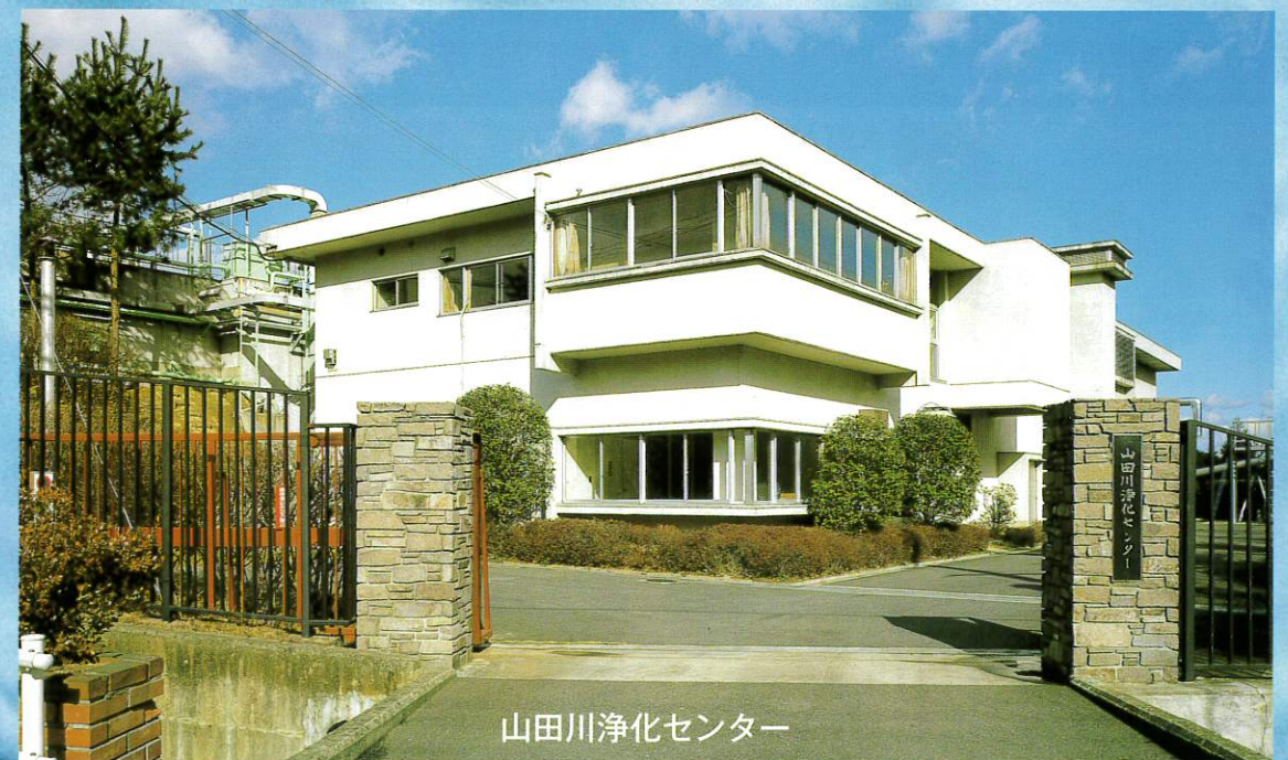
竜田川浄化センター
