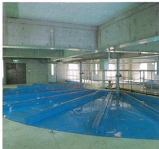
最初沈でん池
