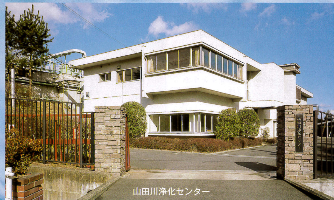
竜田川浄化センター
