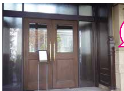
当時はめずらしい鉄筋コンクリート造り
