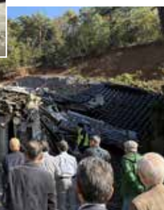
被災現場の視察
