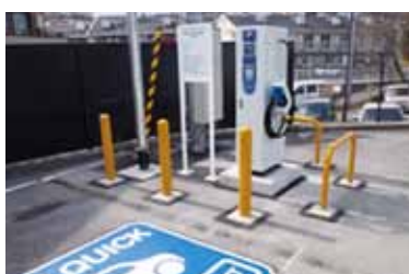
エネルギーステーション
