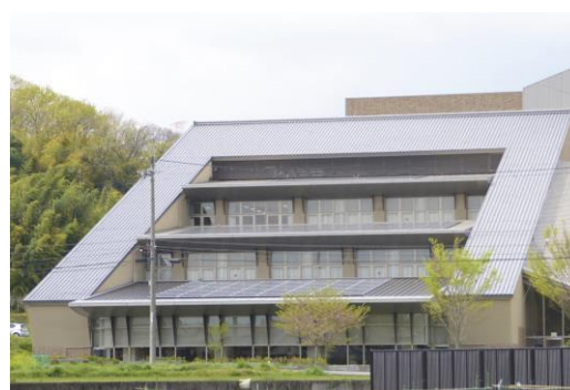
北コミュニティセンターに設置した太陽光発電パネル
