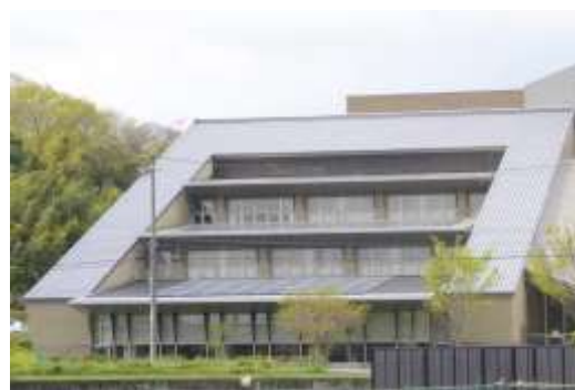
北コミュニティセンターに設置した太陽光発電パネル
