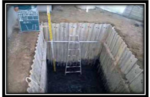
基礎を施工するため、所定の深さまで掘削し、規定面のおりに仕上げられているか。
