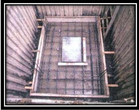
基礎工事の底版コンクリートに配筋している写真
