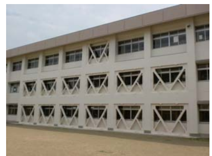
公共施設の耐震改修
