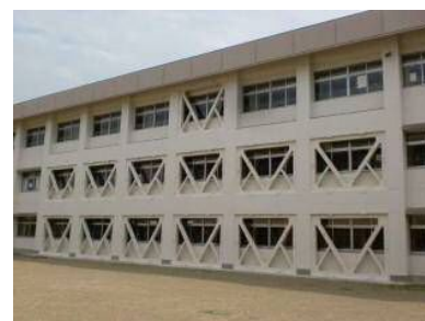
公共施設の耐震改修
