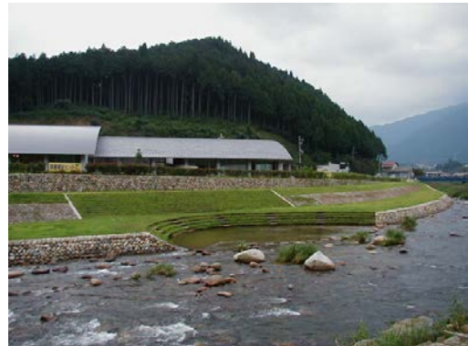
法面を分節化し、緑化を施した例
