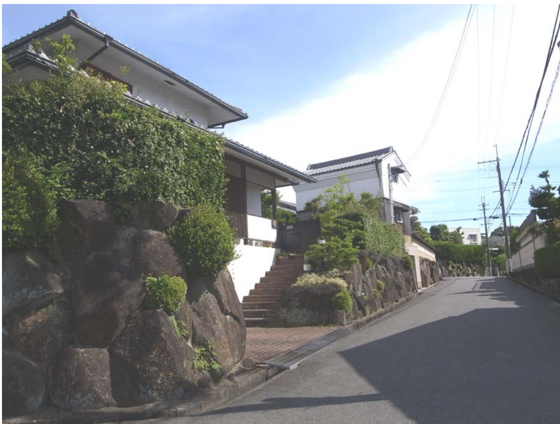
生駒石による石積み（東生駒）
