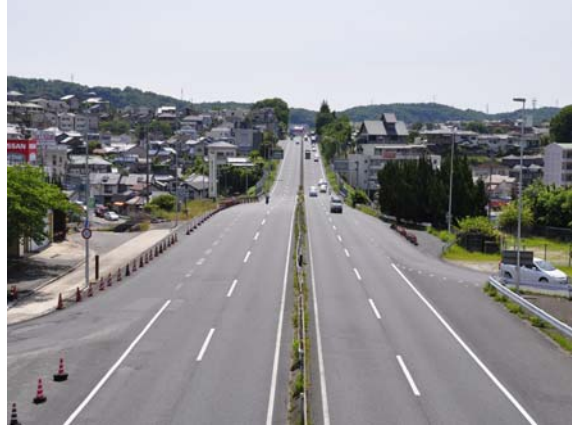
幹線道路の見通し（俵口町）
