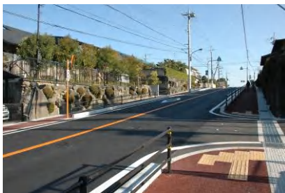
バリアフリー化された歩道
