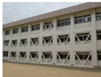
公共施設の耐震改修
