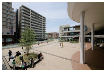
駅前集合住宅とバルコニーステージ(北新町)
