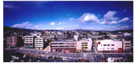
生駒駅前再開発地区
