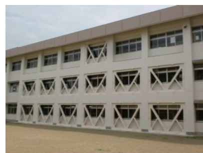
公共施設の耐震改修
