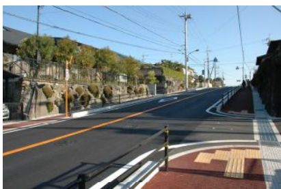
バリアフリー化された歩道
