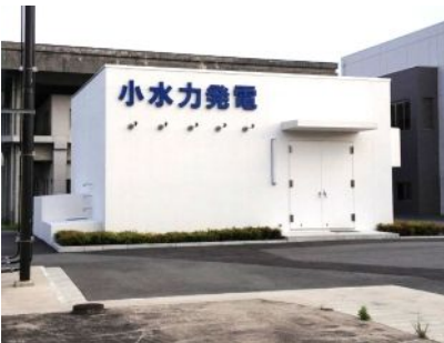
山崎浄水場に小水力発電機を設置。電力買取制度 (FIT) による売電を実施。平成 25 年 3 月稼働。設備容量 40kW。年間発電見込み 35 万 kWh。
