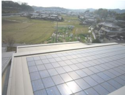
市内公共施設に太陽光発電システムを設置。平成 25 年度末 7 施設 (設備容量 92kW)。写真は北コミュニティセンター ISTA はばたき。
