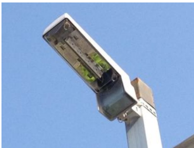
平成 24 年度より、市内の防犯灯、街路灯約 11,000 基を LED 灯に転換。集合住宅共有スペースの照明の LED 化補助も実施予定。
