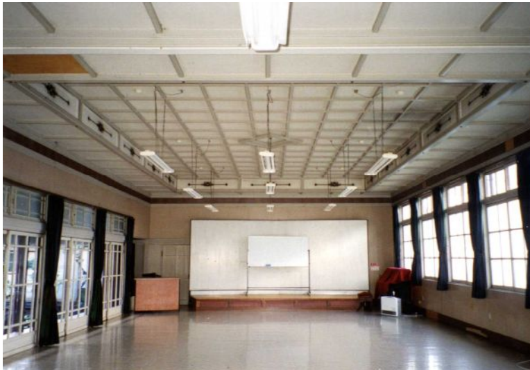
旧生駒町役場庁舎内 会議室(現 市民ホール別館)
