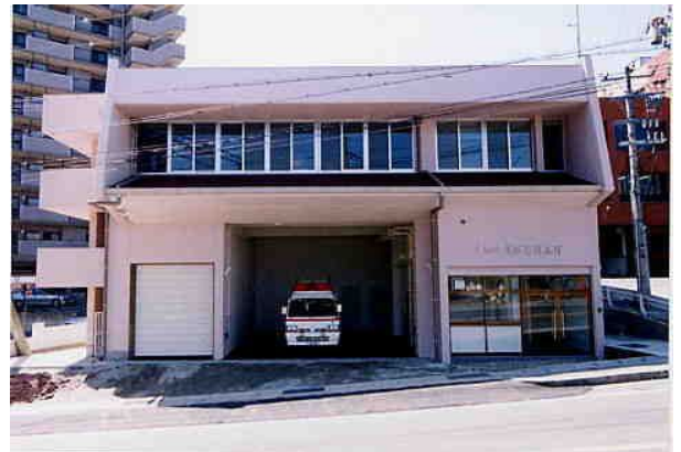
山崎町旧郷土資料館（現在救急施設）
