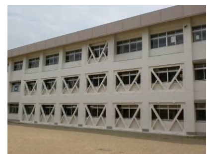
公共施設の耐震改修
